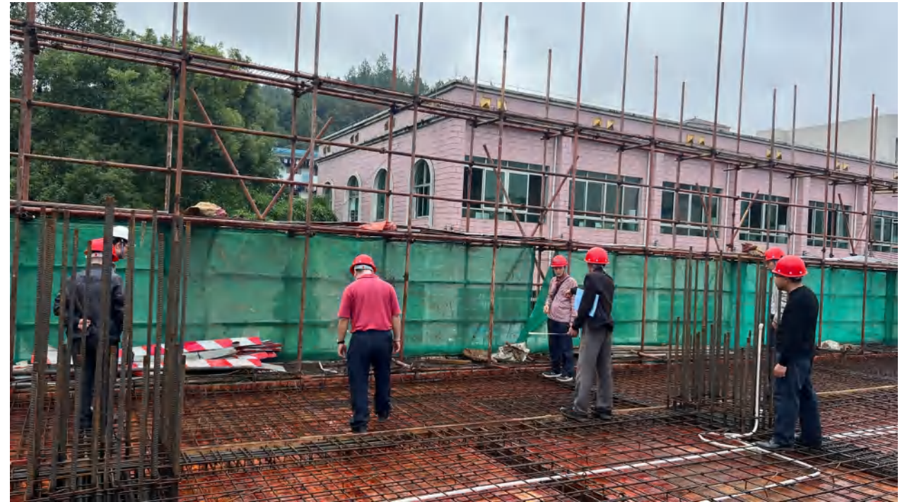
◎ 11 月 29 日基金会、仁化中学、设计单位、仁化质监站、施工单位及监理单位相关人员到仁化中学综合楼五楼进行钢筋验收
