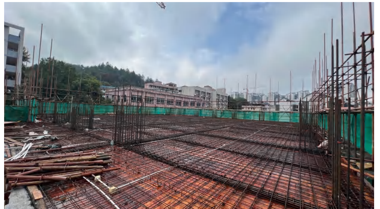
◎ 11 月 29 日仁化中学综合楼五楼钢筋验收现场
