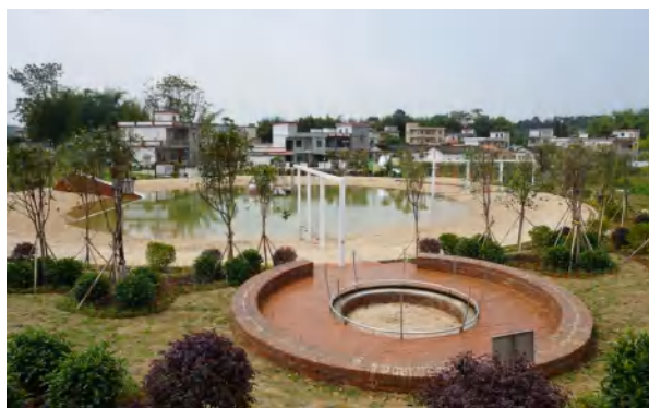
◎新龙村田园公园基础设施建设后
