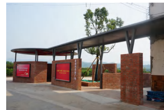
◎新龙村党建广场改造后
