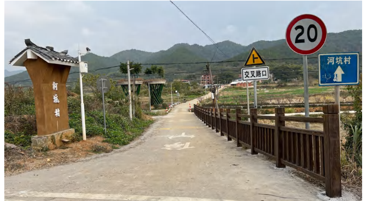
◎ 1月18日基金会对河坑村入口护栏安装工程竣工验收
