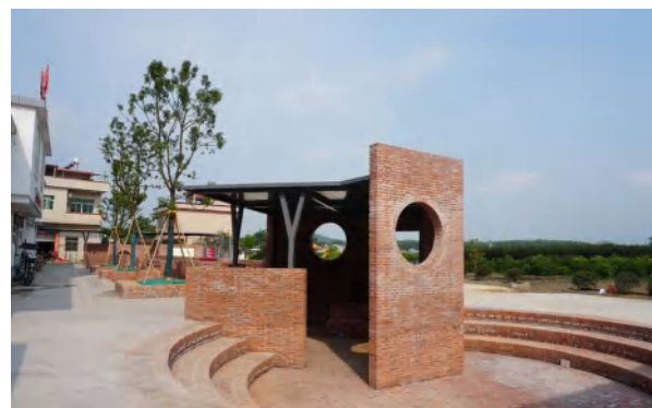
◎新龙村党建广场改造后
