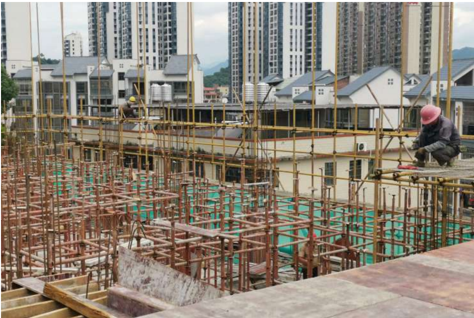
· 建设中的宿舍楼
