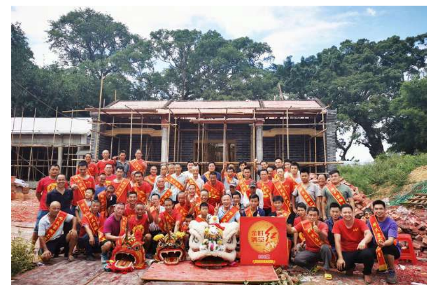
· 建设中的祠堂
