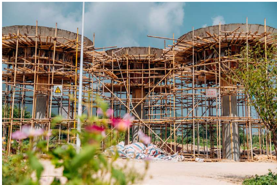
· 建设中的树生亭
