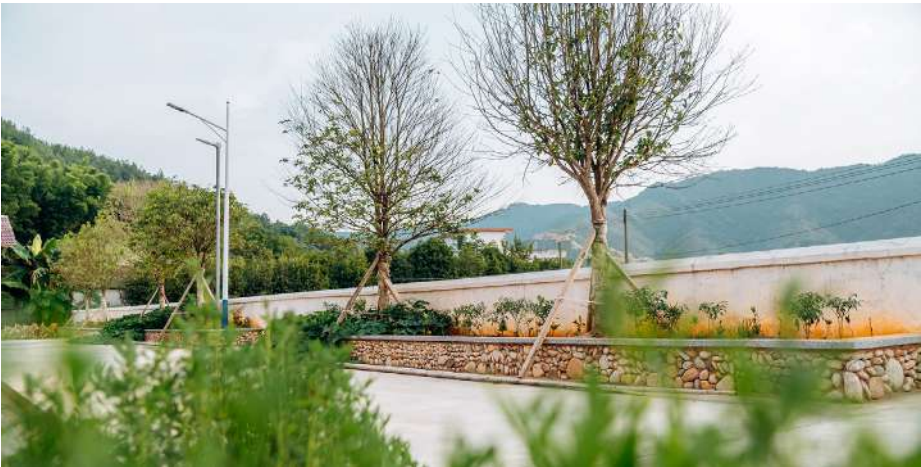
· 竣工后的曾屋祠堂前广场
