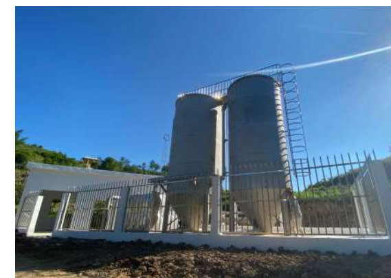
· 里东村预沉池及泵房
