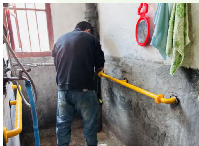
○ 对照卫生间的尺寸与布局，施工人员细心调整扶手的安装位置与角度
