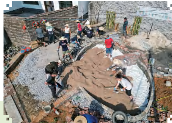
▲ 砌砖组成员正在进行填充沙池
