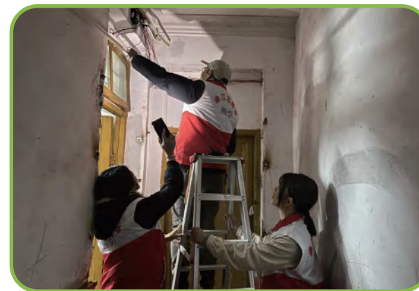
▲ 走廊线路改造中
